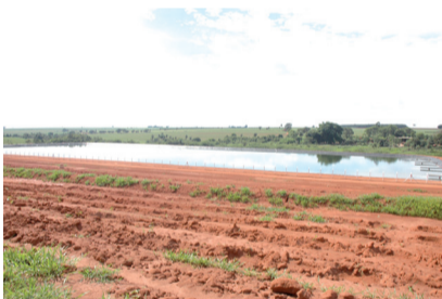
A lagoa de tratamento
