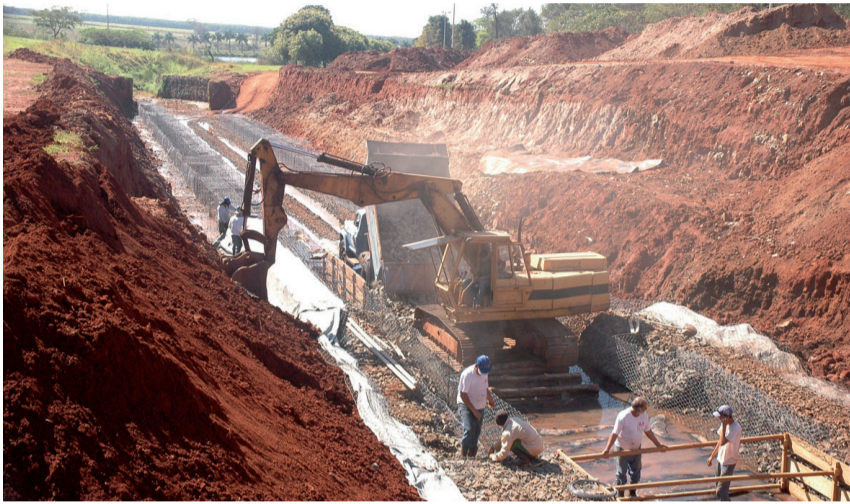
MÃOS À OBRA: Homens e máquinas trabalham na construção da galeria
