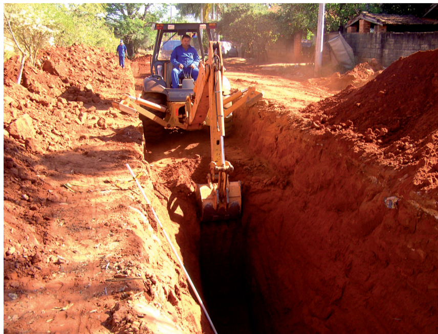
SANEAMENTO DE QUALIDADE: Foram feitas mais 100 ligações de água e esgoto
