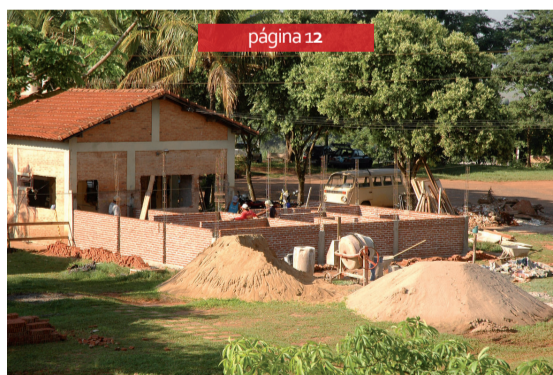
INFRAESTRUTURA: Ampliação permitirá melhoria das condições de serviço.
