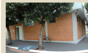
Prédio tem rampa de acesso para cadeirante
