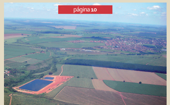
● Estação de Tratamento de Esgoto
