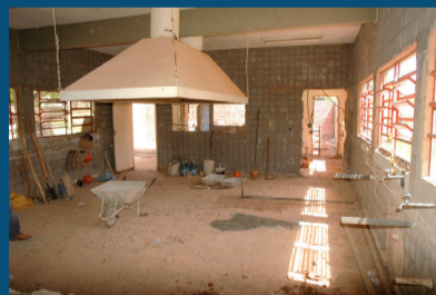
Refeitório também está sendo reformado
